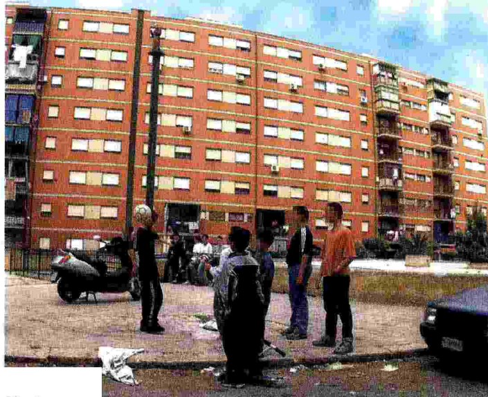
Periferie e degrado. Il quartiere Bonagia a Palermo. FOTO: ANSA
